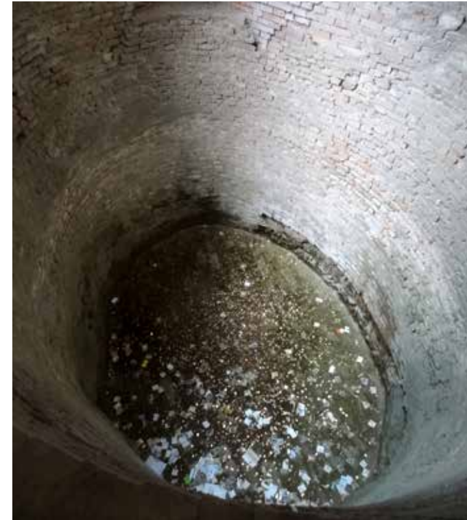
Die Neviera im Keller des grossherzoglichen Palastes von Urbino (Mittelitalien) La Neviera dans la cave du Palais du grand-duc d'Urbino (Italie centrale)
