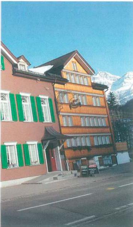
«Rossfall» le long de la route de transit
