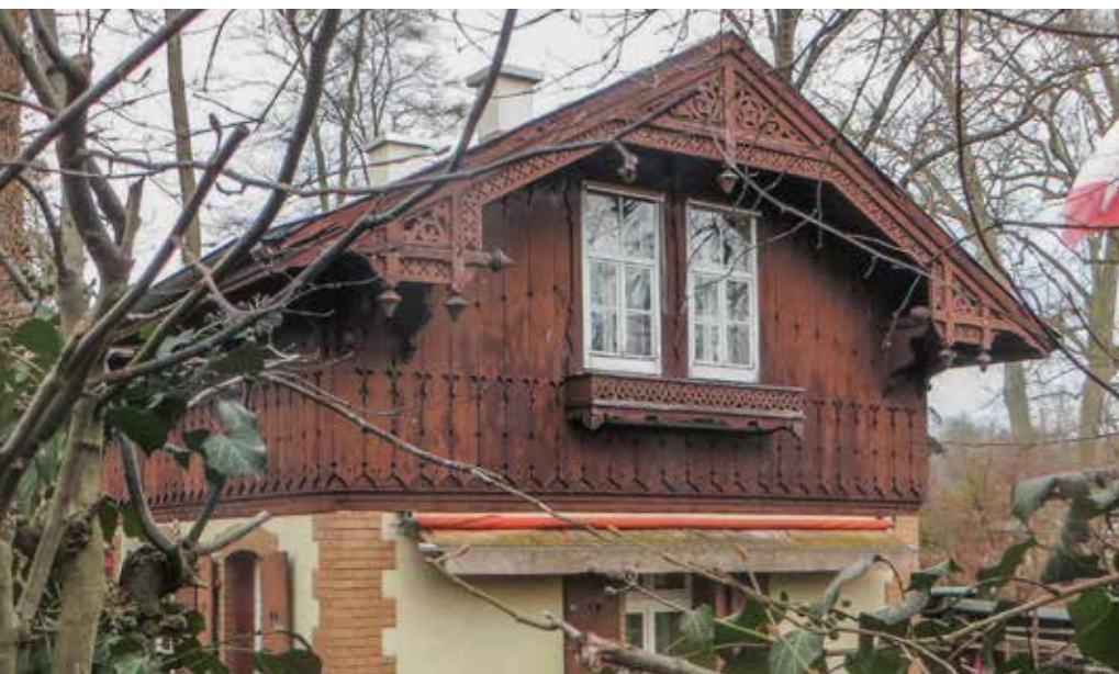
Gärtnerhaus beim Tierpark in der Langen Erlen, Basel. Cabane de jardinier dans le parc animalier Lange Erlen, Bâle.
